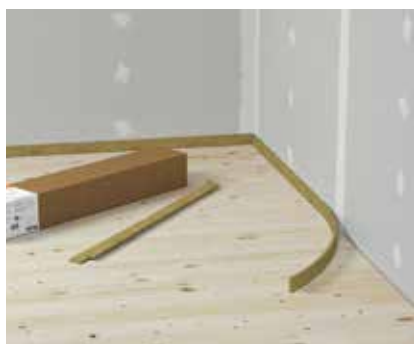
❶ Polaganje rubne izolacijske trake i usko spajanje u kutove
