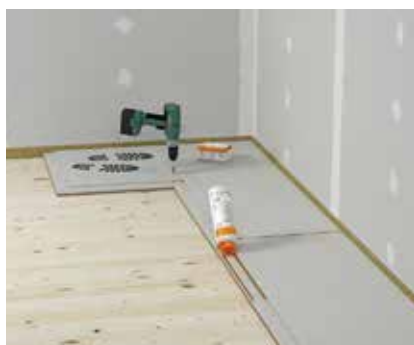
❹ Nanošenje ljepila za estrih fermacell™ na područje utora
