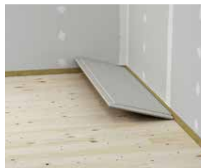
❸ Polaganje estrih elementa fermacell®
