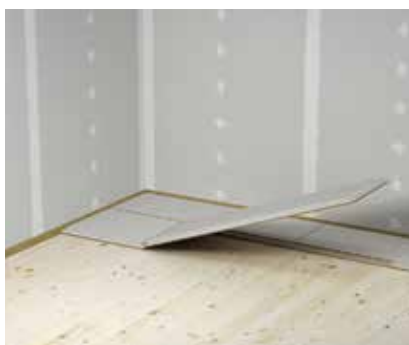
❺ Lijepljenje elemenata s potpuno ispunjenim spojevima
