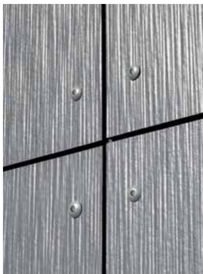
Pričvršćivanje obloge Hardie® panel zakovicama
