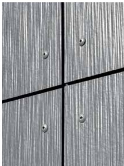
Pričvršćivanje obloge Hardie® panel vijcima
